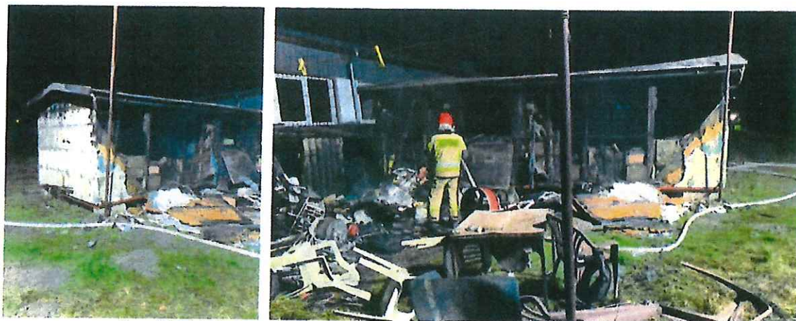
Rys. 30 i 31. Pożar obiektu tymczasowego o funkcji mieszkalnej w Siedlicach.
